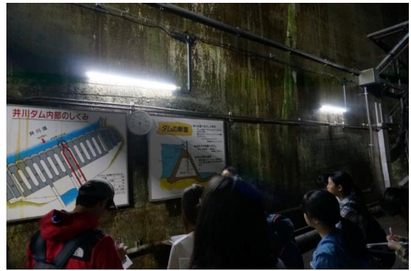
写真 1-2 井川ダム見学
